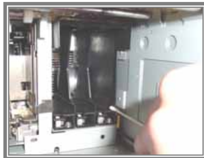
図 5-15 固定スロット内面のクリーニング
