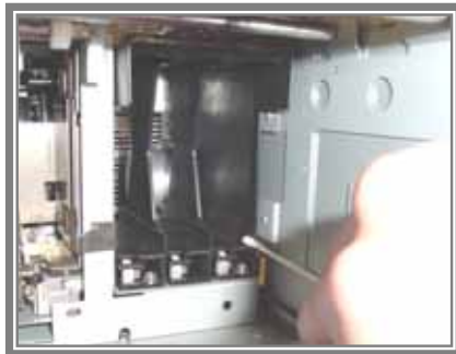
図 5-15 固定スロット内面のクリーニング
