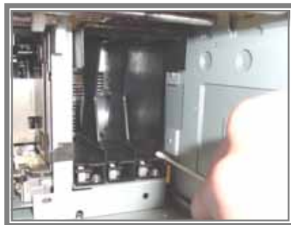
図 5-15 固定スロット内面のクリーニング
